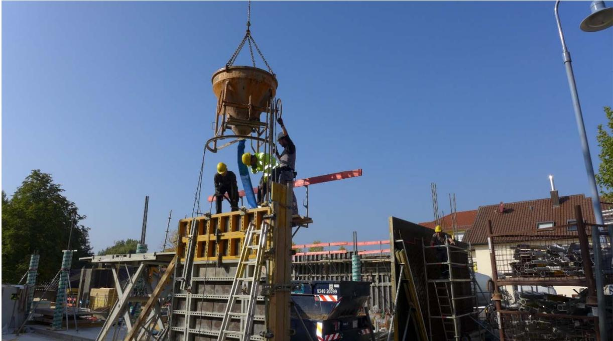
*Zug um Zug werden Wandteile eingeschalt, armiert und anschließend betoniert.*
