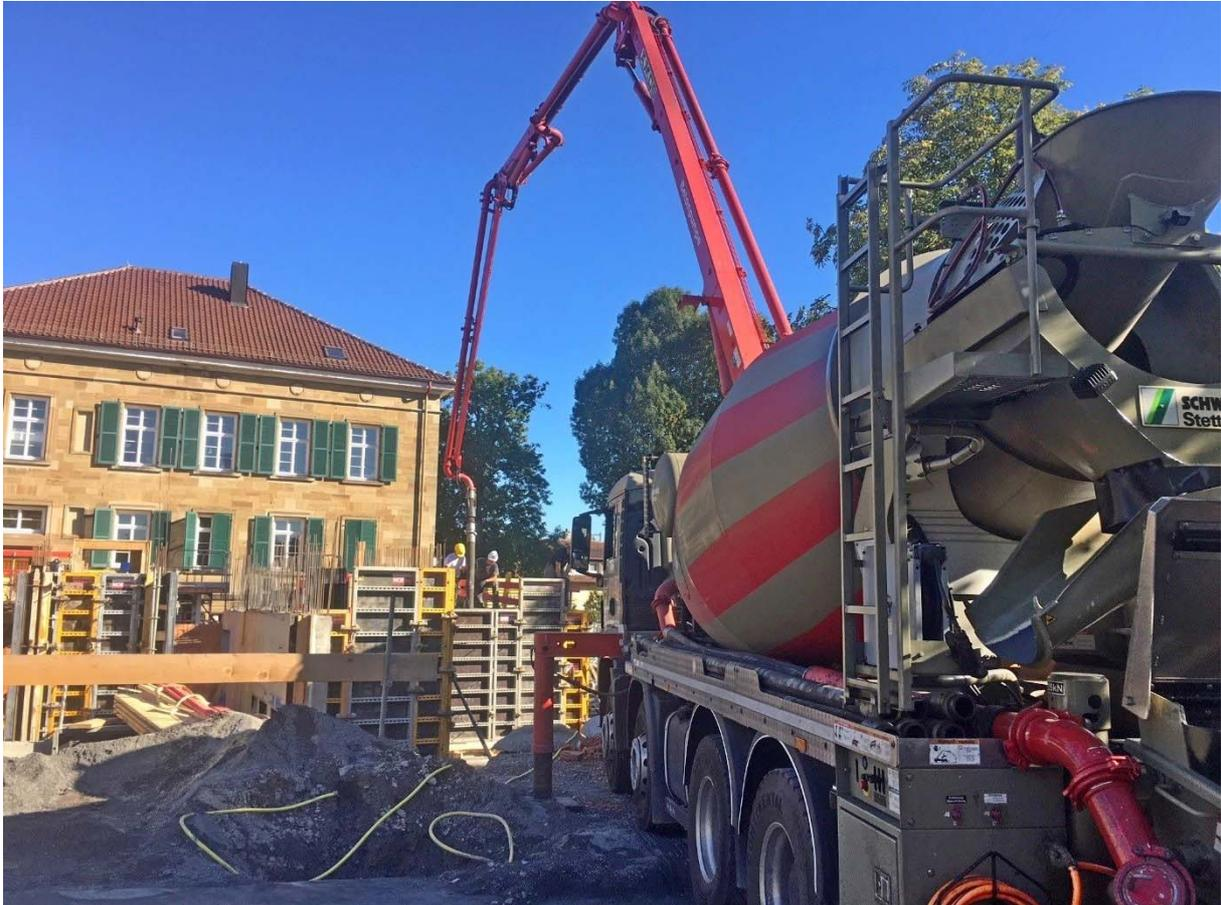
*Mit Hilfe einer Betonpumpe wird der Beton in die Wandschalung befördert und gleichzeitig mit Hilfe eines Rüttlers verdichtet.*
