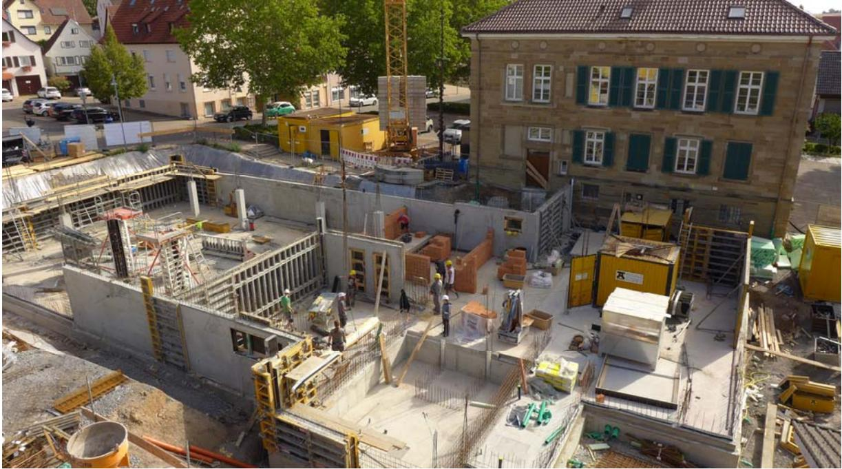
Inzwischen ist der Grundriss des neuen Rathauses und auch die Aufteilung der Kellerräume gut erkennbar. Am Rathaus-Altbau steht schon die nördliche Kellerwand des Verbindungselementes; im Bild-Vordergrund sind das Treppenhaus und darin die Armierung des Fahrstuhlschachtes zu erkennen. Schon in der nächsten Woche soll mit den Arbeiten der Kellerdecke begonnen werden.
