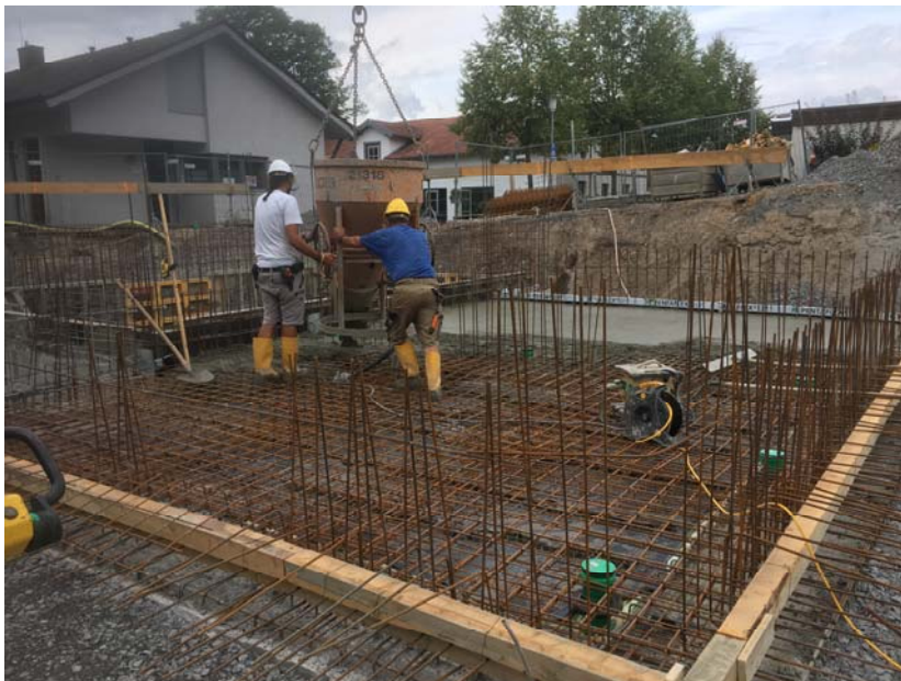
Betonkübel für Betonkübel lässt Polier Urbscher auf die Armierung fließen, ehe der Beton ebengezogen wird.
