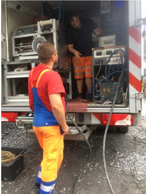
Mitarbeiter der Firma Lutz bei der Druckprüfung der Abwasserrohre. Nachdem die Druckprüfung die Dichtheit bestätigte konnte die Bodenplatte betoniert werden.
