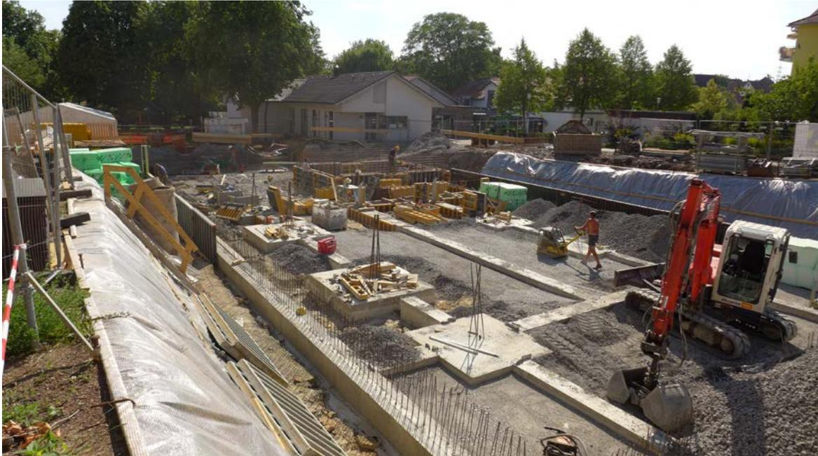
Im Bereich des Technikellers und des Fahrstuhlschachtes wurden bereits die ersten Umfassungswände betoniert.
