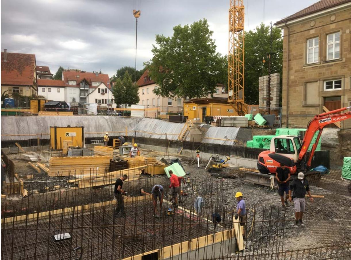
*Diese Bodenplatte wird nun mit Baustahl armiert und dann betoniert.*
