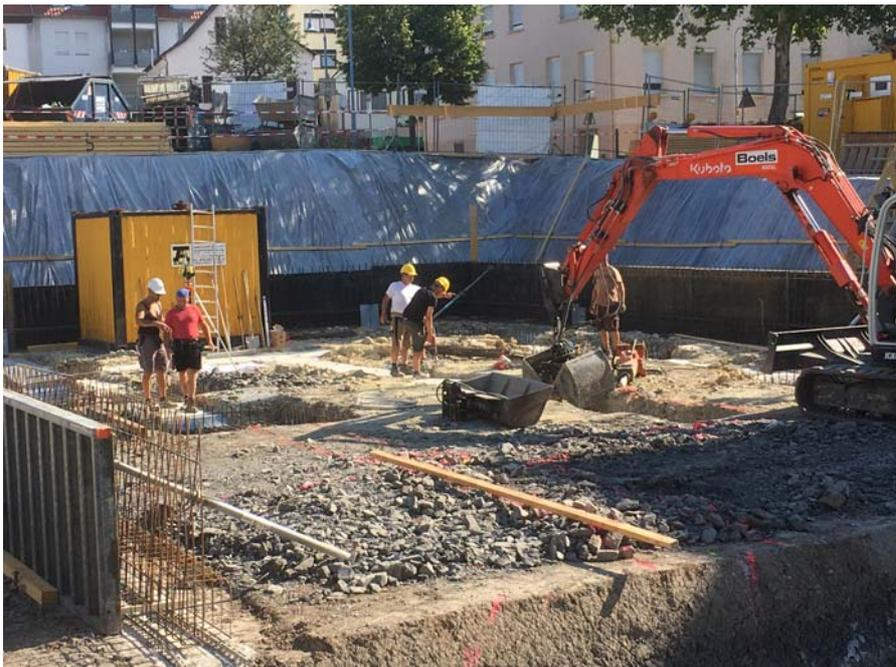
*Die äußeren Streifenfundamente sind bereits geschalt und bewehrt. Für die tragenden Wände und Stützen werden Fundamentgräben ausgehoben.*
