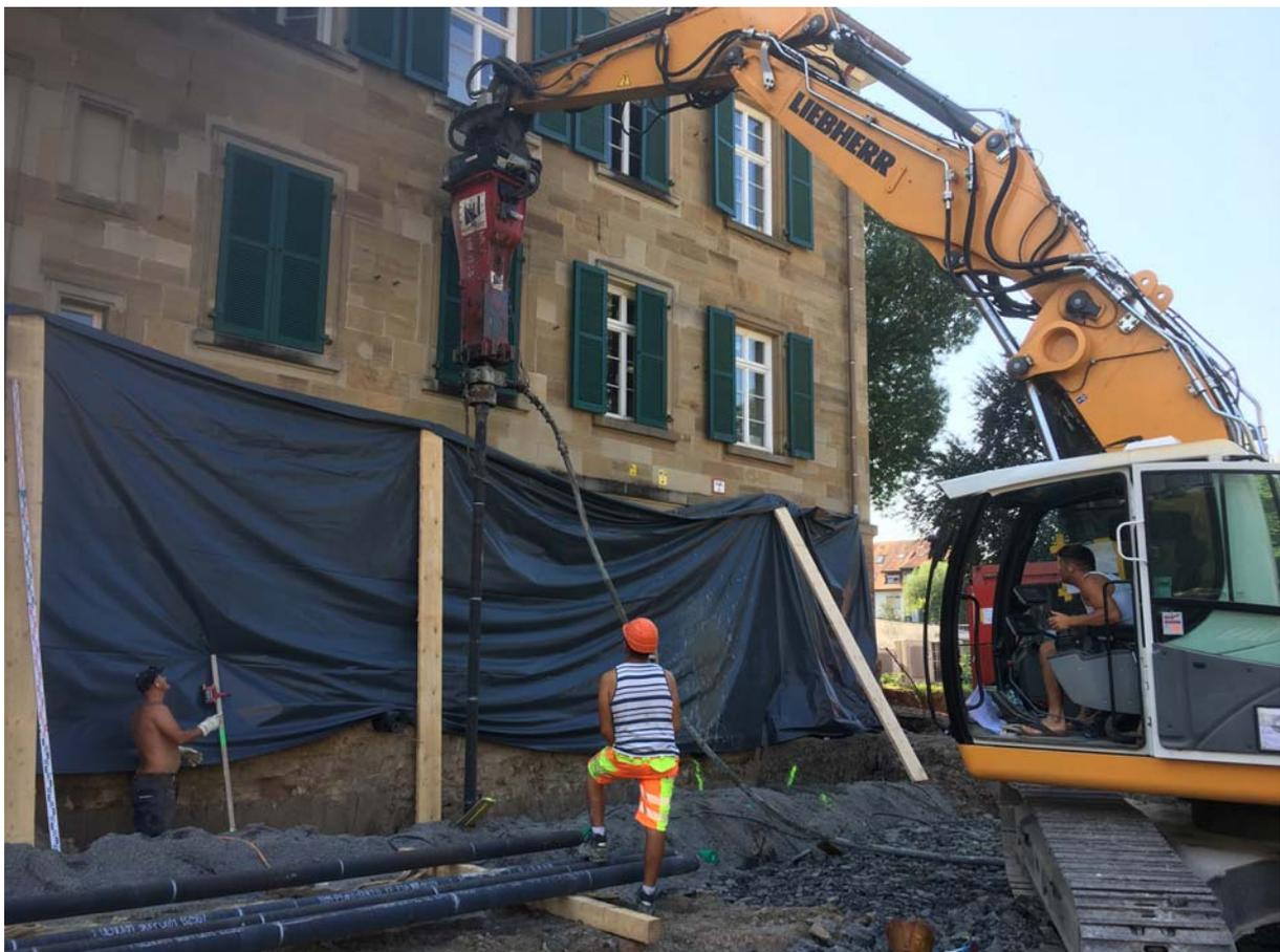
*Die Lage der Bohrpfähle wurde zuvor durch Bodengutachten ermittelt, der Standort vom Geometer eingemessen und für jeden Bohrpfahl ein exaktes Bohrprotokoll angefertigt.*
