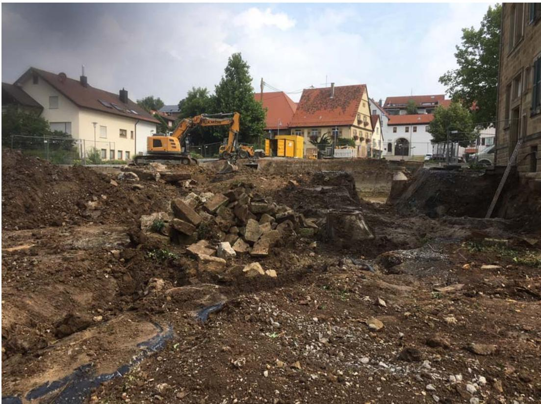
*Im Gegensatz zum früheren Rathausnebengebäude wird der Neubau vollständig unterkellert. Doch zuerst muss die Baugrube ausgebaggert werden.*
