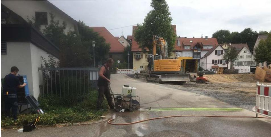
*Die Versorgung der Baustelle und des Baukrans mit Baustrom erfolgt aus der Trafostation neben den Garagen im Ortszentrum. Da mit den Leitungen die Zufahrt zu den Parkplätzen im Ortszentrum gekreuzt werden muss, hat sich die Firma Amos gegen eine Leitungsbrücke und für eine unterirdische Verlegung entschieden. Hierzu wird, wie auf dem Bild ersichtlich, zunächst der Asphalt angeschnitten.*
