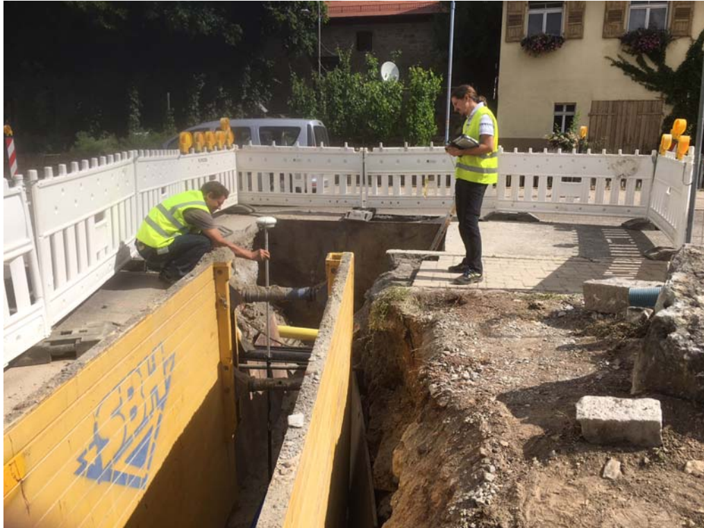
Die neuverlegten Leitungen werden nach Lage und Höhe eingemessen
