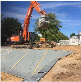
Die letzte "Fuhre" Abbruchmaterial steht zum Abtransport auf die Deponie an, die Seitenwände der Baugruben der beiden Teilunterkellerungen sind zum Schutz gegen Erosion abgedeckt.
