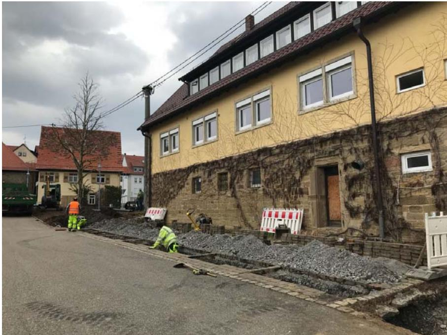
*Mitarbeiter der Fa. Omexom beim Verlegen der neuen Leitungen im ausgehobenen Leitungsgraben*
