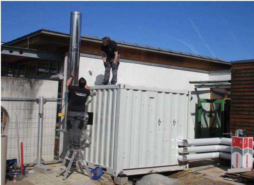
*Mitarbeiter der Firma Klotzbücher installieren den Kamin für die provisorische Heizanlage, die die Bestandsgebäude über die Bauzeit mit Wärme versorgen wird.*
