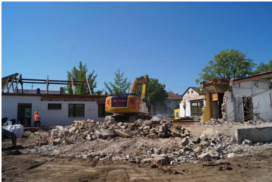
Der Kindergartenaltbau ist bereits zu großen Teilen abgebrochen
