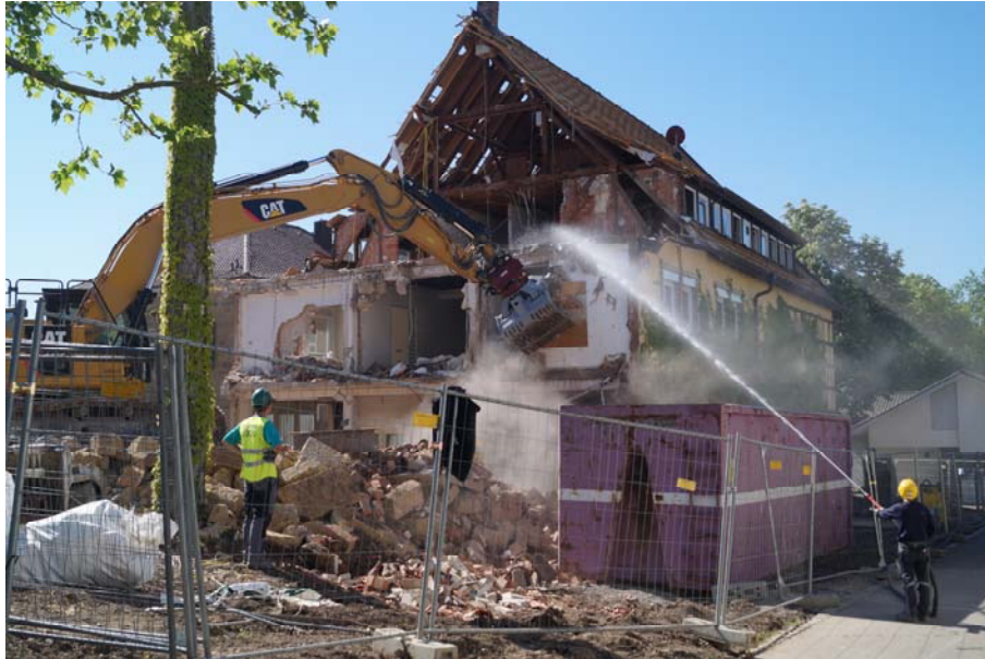
Das alte Rathaus-Nebengebäude wird Stück für Stück abgerissen
