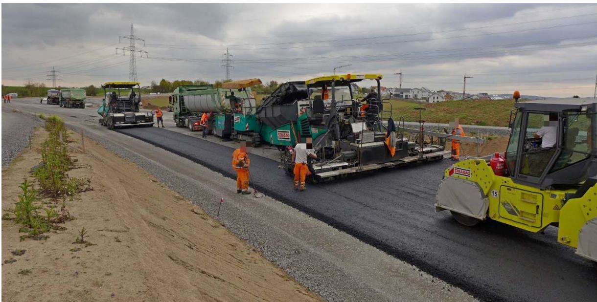
*Wirklich beeindruckend für Zaungäste, wie im Laufe weniger Stunden aus einer Schotterpiste eine Straße wird. Zwar im „Schneckentempo“, aber kontinuierlich wird Meter um Meter das Asphaltband in die Landschaft gelegt.*
