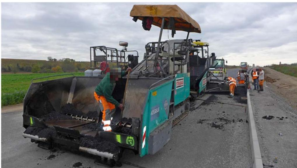
*Nur ganz selten und nur wenige Minuten ist der Aufnahmebehälter des Asphaltbeschickers leer, bevor der nächste LKW sein Mischgut abkippt. Diese Gelegenheit wird sofort genutzt, in den Ecken liegendes Mischgut direkt an die Schnecke zu bringen und mit Trennmittel ein Verkleben der Maschine zu verhindern.*
