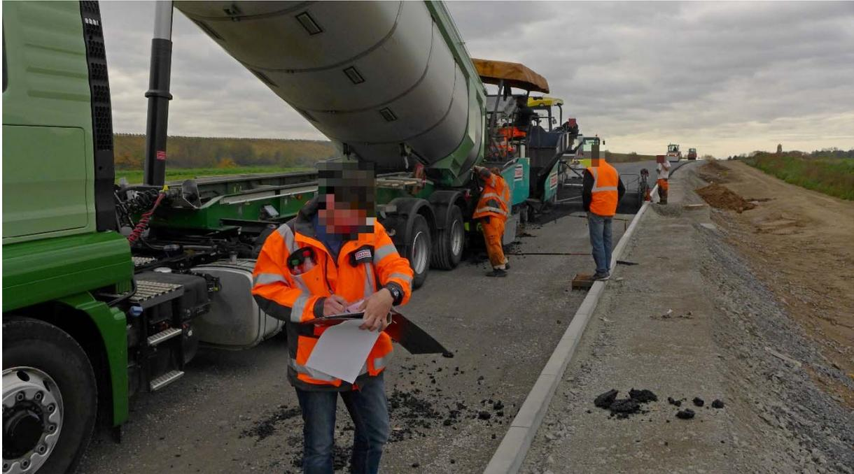
*Sowohl vor als auch hinter dem Fertiger wird ständig kontrolliert und protokolliert. Stimmt z.B. die Temperatur, mit der eingebaut wird? 160 – 180 ° heiß ist der Asphalt, der aus einem Werk bei Pforzheim nach Nordhausen gefahren wurde.*
