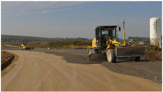
Mit dem vorderen Schild des sogenannten Graders wird der Schotter grob verteilt. Dann hilft dem Fahrer moderne Technik. Das zweite Schild ist GPS-gesteuert; die Empfangseinheit ist rechts von der Fahrerkabine gut erkennbar. Die vorgegebene Höhe der sogenannten Frostschutzschicht von 30 cm wird exakt eingehalten.
