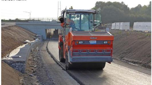
Der Asphalt ist aufgebracht und wird abgewalzt. Sorgfältig beobachtet der Fahrer, wie gleichzeitig der Rand der künftigen Fahrbahn geschnitten und angedrückt wird.
