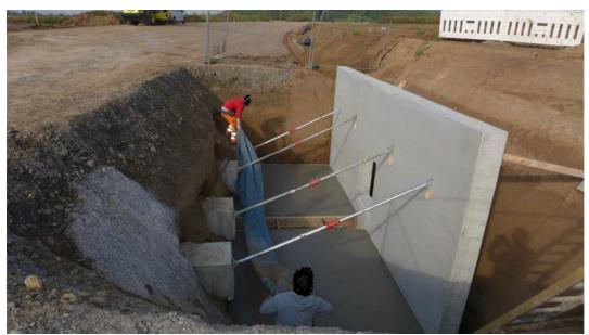
Rechts und links der Straße werden sogenannte Portalwände errichtet. Das "Portal", der Zugang zum Tunnel, der unter der Straße durchführt, ist deutlich erkennbar. Außerhalb wird eine Rampe gestaltet, welche die Tiere zum Tunnel hinab führt.
