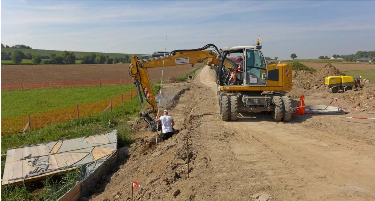
Dort im Bereich des Baches wird schon das Setzen von Leitwänden für Amphibien vorbereitet. Diese sollen vom Versuch abgehalten werden, die neue Straße zu überqueren. Auch die links im Bild erkennbare Holzkonstruktion ist eine Maßnahme des Naturschutzes; in den dort unter der Straße durchfließenden Breibach soll möglichst kein unnötiges Material eingetragen werden.
