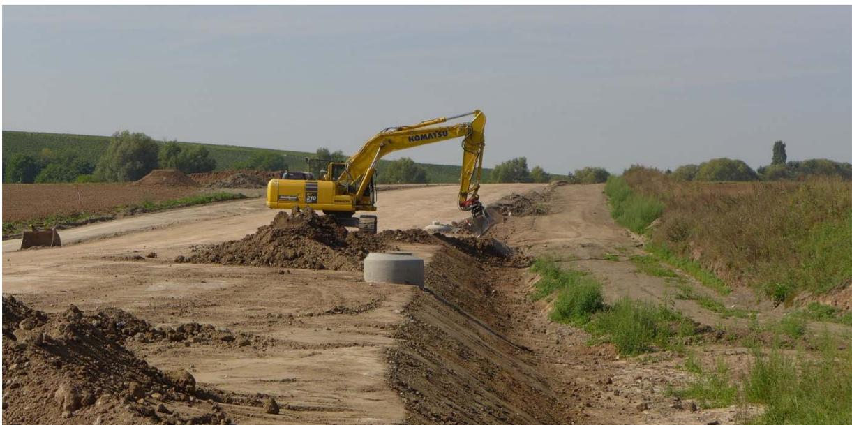
Parallel zieht der Bagger den Straßenkörper im aufgeschütteten Bereich auf die Sollbreite ab. Aufgebaut und verdichtet wurde in Überbreite; auch dies, um eine möglichst gute Standfestigkeit zu erreichen.
