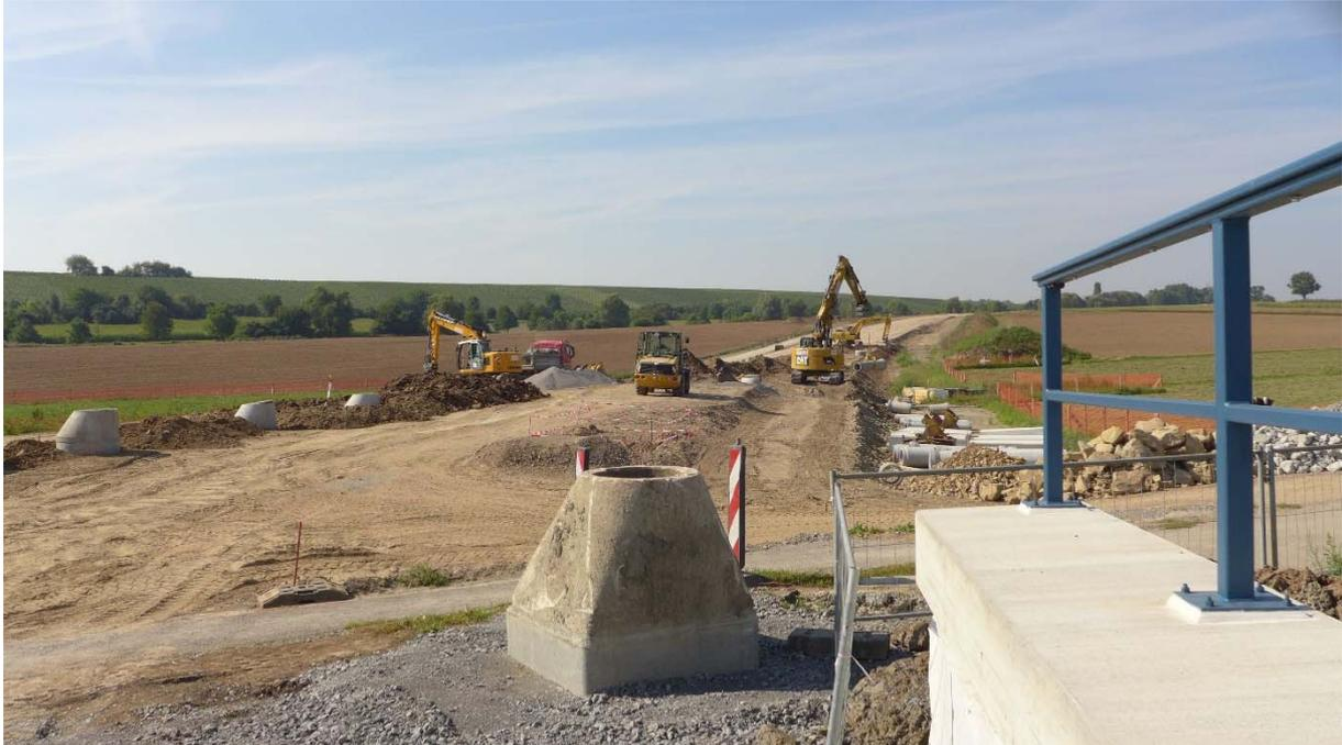
Wie hoch der Straßenaufbau letztlich ungefähr wird, kann man am Kanalschacht in der Bildmitte im Bild sehen. Unter diesem Schacht läuft der Schmutzwasserkanal von Nordhausen Richtung Nordheim, der natürlich auch künftig zugänglich sein muss.
