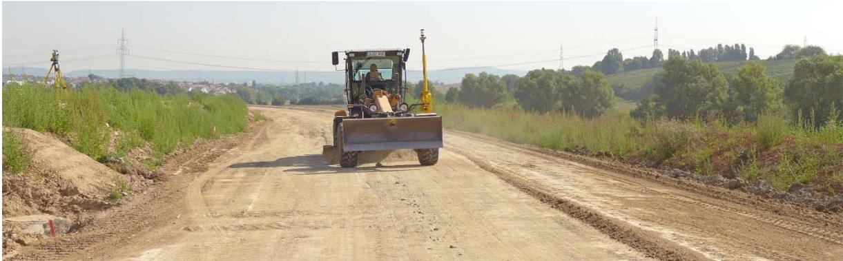
Im Bereich südlich von Nordhausen bringt der Gräber schon das Planum exakt auf Höhe. Im nächsten Schritt wird in die oberen 30 Zentimeter ein Mischbinder eingearbeitet, der zu je 50 % aus Kalk und Zement besteht. Dies bewirkt eine starke Standfestigkeit dieser oberen Schicht, auf der dann Lage um Lage, beginnend mit der Frostschutztragschicht, die Straße regelgerecht aufgebaut wird.
