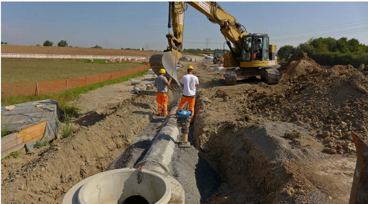
Nicht für Schmutzwasser im üblichen Sinne sind die Straßenentwässerungskanäle da, deren letzte Meter gerade hergestellt werden. Die gesamte Straßenentwässerung erfolgt über die neu gebauten Einrichtungen im Bereich zwischen Verbindungsweg und Breibach nahe dem Biotop Seewiesen.
