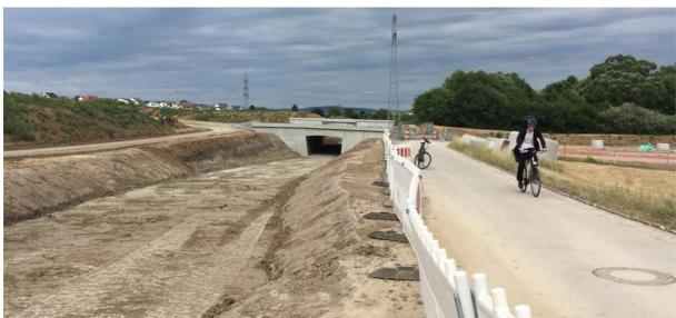
Im Bereich der Radwegunterführung zwischen Nordhausen und Nordheim ist auch schon die Trasse geschoben und gut erkennbar, wie der neue Weg künftig unter der Ortsumfahrung durchführen wird. Weshalb eigentlich? Ganz einfach und am Kanaldeckel rechts im Bild erkennbar: der Abwasserkanal, der im bisherigen Feldweg verläuft, macht es unmöglich, diese bestehenden Weg tiefer zu legen. Auch die Ortsumfahrung auf einen höheren Damm zu bauen, wäre keine gute Alternative gewesen.
