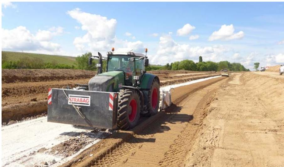
*Mit PS-starkem Gerät wird die Fräse angetrieben, die den gut erkennbaren weißen Kalk in den Boden einarbeitet. Hinterher kommt die Walze und verdichtet, so dass ausreichende Tragfähigkeit besteht.*
