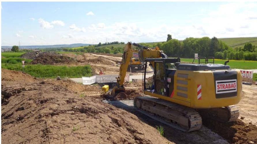
*Die Kreisstraße ist mit dem Regenwasserkanal überquert; der Bagger arbeitet sich weiter bis zum Bauanfang, was in unserem Fall für den Kanal das Ende ist.*
