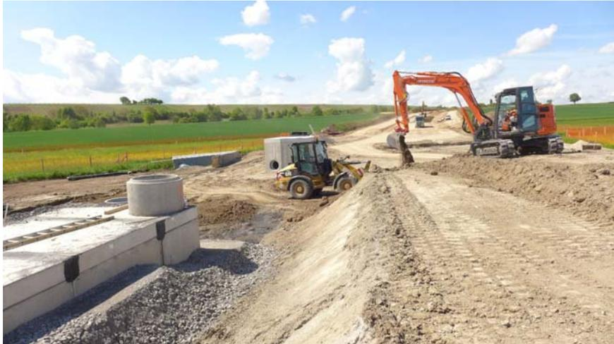
*Links ist einer der Einstiege ins Regenklärbecken zu sehen; hinter dem Radlader steht schon das Regenüberlaufbauwerk. Parallel wird das geplante Rückhaltebecken profiliert und der Damm im Vordergrund aufgebaut; im Hintergrund sieht man unter der Baggerschaufel einen der großen LKW's, welche in dieser Woche mit der Anlieferung des notwendigen Fremdmaterials begonnen haben.*
