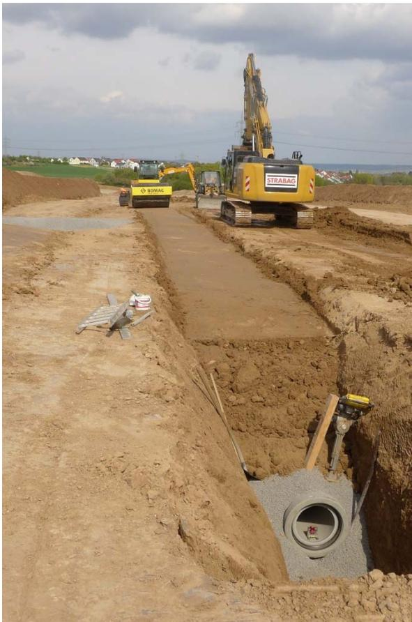
*Kanalrohr für Kanalrohr wandert in den Graben, der anschließend lagenweise verfüllt und verdichtet wird. Ob sich die Autofahrer, die später an Nordhausen vorbeifahren, Gedanken über die Infrastruktur machen, die für so eine Straße erforderlich ist?*
