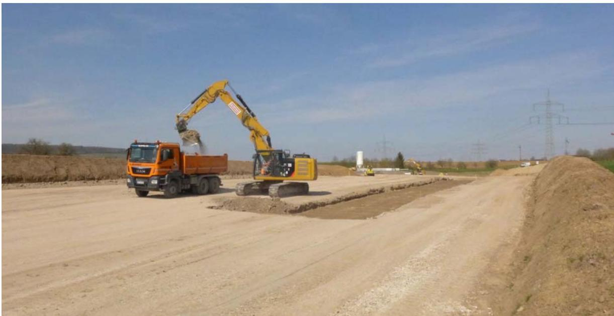
*Entsprechend der höhenmäßigen Straßenplanung wird der mit Weißfeinkalk verbesserte Boden abgetragen und dort verwendet, wo aufgebaut werden muss. Der Weißfeinkalk wird in den Boden eingearbeitet, damit der Wassergehalt im Boden im optimalen Bereich liegt; so kann am besten eingebaut und verdichtet werden und es kommt später nicht zu Setzungen.*
