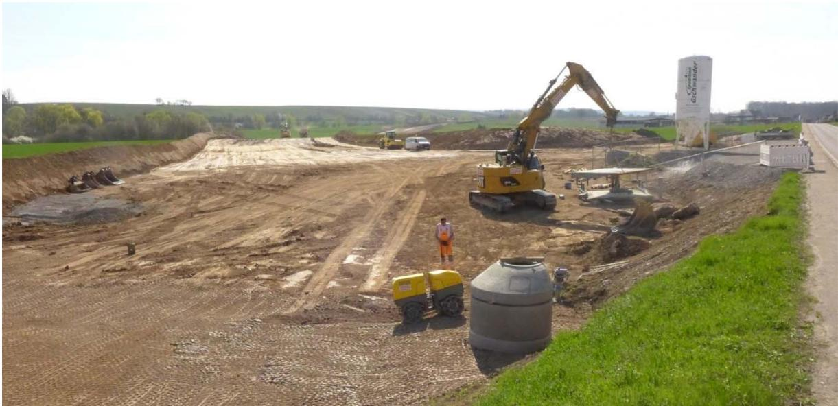
*Nun ist auch die Verdolung des Grabens im Gewinn Geroldsgrund schon abgeschlossen. Der Graben wird verdichtet und nun folgt der lagenweise Aufbau des Geländes bis zur notwendigen Höhe.*
