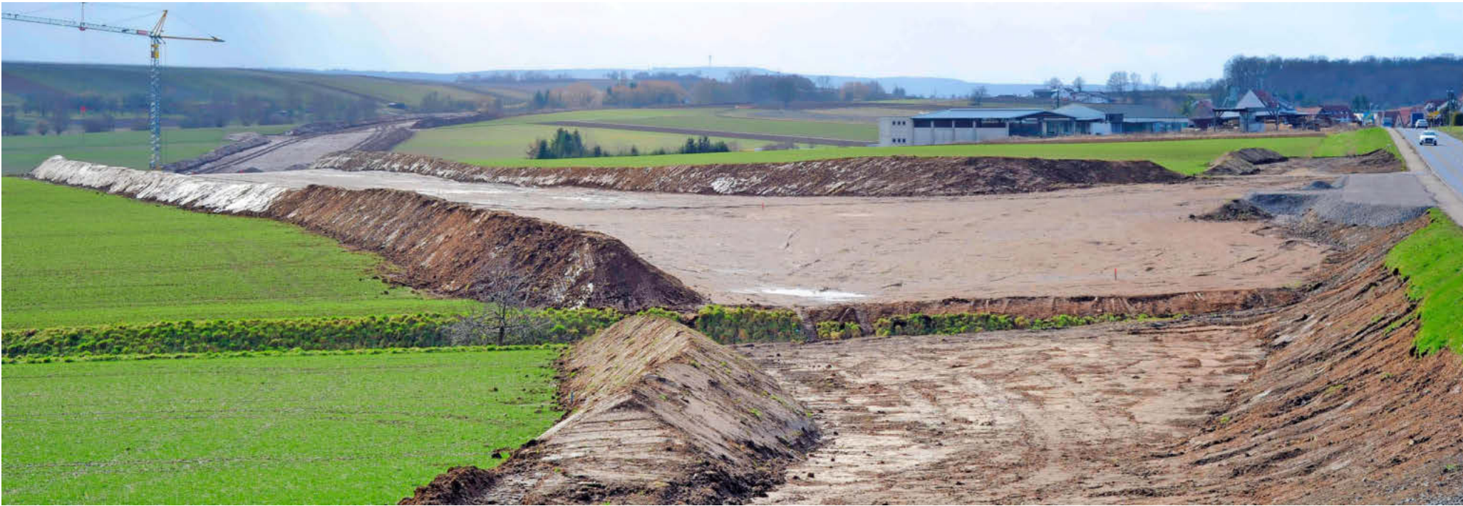
Der Arbeitsraum der zwei Kilometer langen Trasse ist 30 Meter breit. Später bleibt eine 7,50 Meter breite Fahrbahn mit zusätzlichen Wirtschaftswegen für die Landwirtschaft. Bauende ist spätestens im März 2018.
