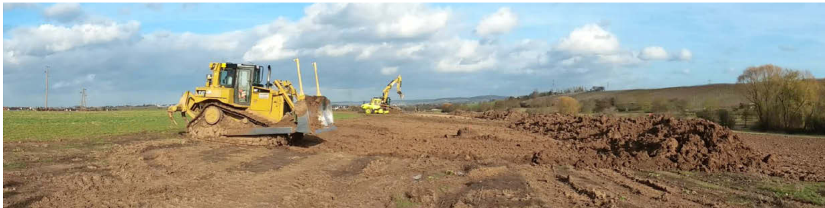
Die Raupe räumt den wertvollen Mutterboden ab. Die Erdhaufen wird angehäuft, modelliert, eingesät und nach Abschluss des Projekts wieder eingebaut. Foto: Rolf Muth
