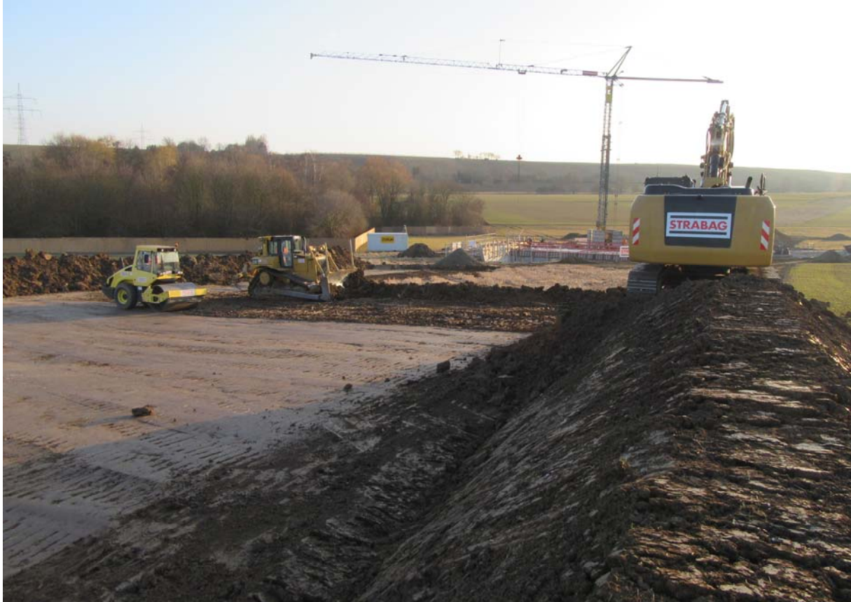
Abtrag des Oberbodens
