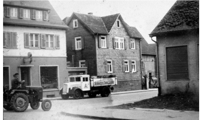
Cafe Weiss Ecke Lauffener Straße und Hauptstraße
