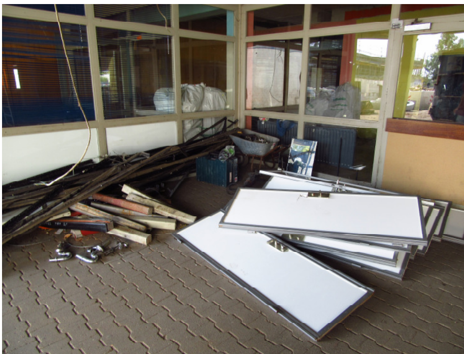
Deckenverkleidungen, Bodenbeläge, Wandfliesen und technische Einrichtungen werden Zug um Zug entfernt.
