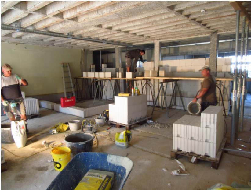
Im Altbauteil werden neue Zwischenwände eingezogen.
