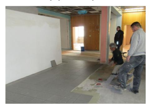
In den Klassenzimmern im Erdgeschoss wurde der Linoleumbelag auf den vorbereiteten Untergrund verlegt und mit einer Schutzabdeckung abgedeckt. Damit die weitere Benutzung durch den Maler und Deckenbauer möglich ist.
