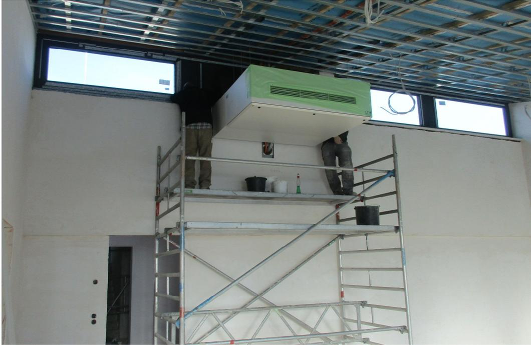
In Gebäude A ist die Unterkonstruktion der abgehängten Decke bereits montiert. Hier werden zurzeit noch Fenstersimse eingebaut.
