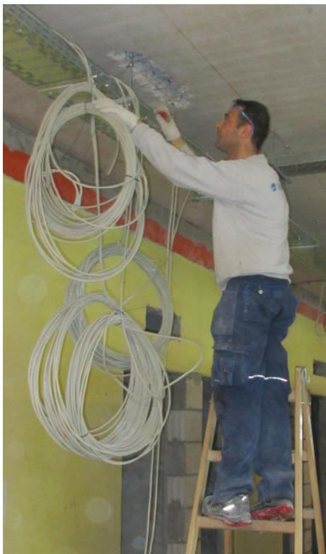
Im Gebäude werden zudem weiter Leitungen verlegt, ehe die Unterkonstruktion der abgehängten Decken eingebaut wird.
