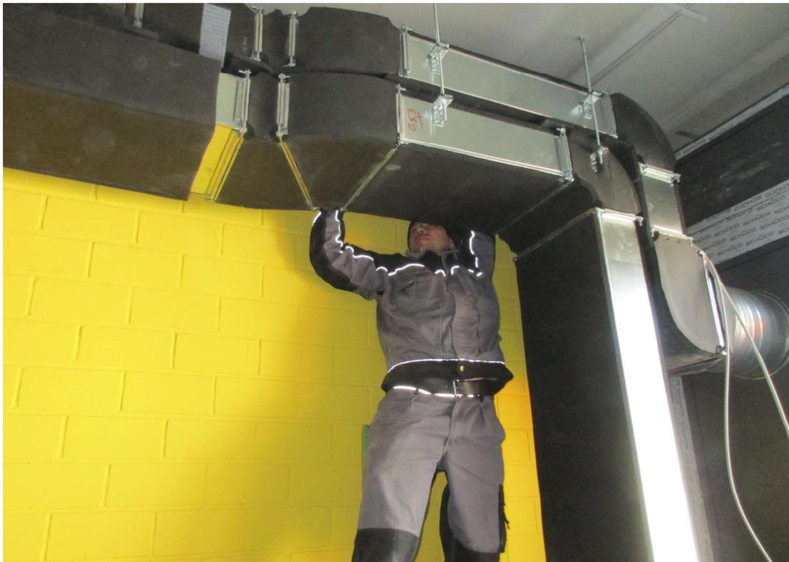
Im Gebäude D wurden Lüftungsleitungen eingebaut. Diese werden zurzeit gedämmt.
