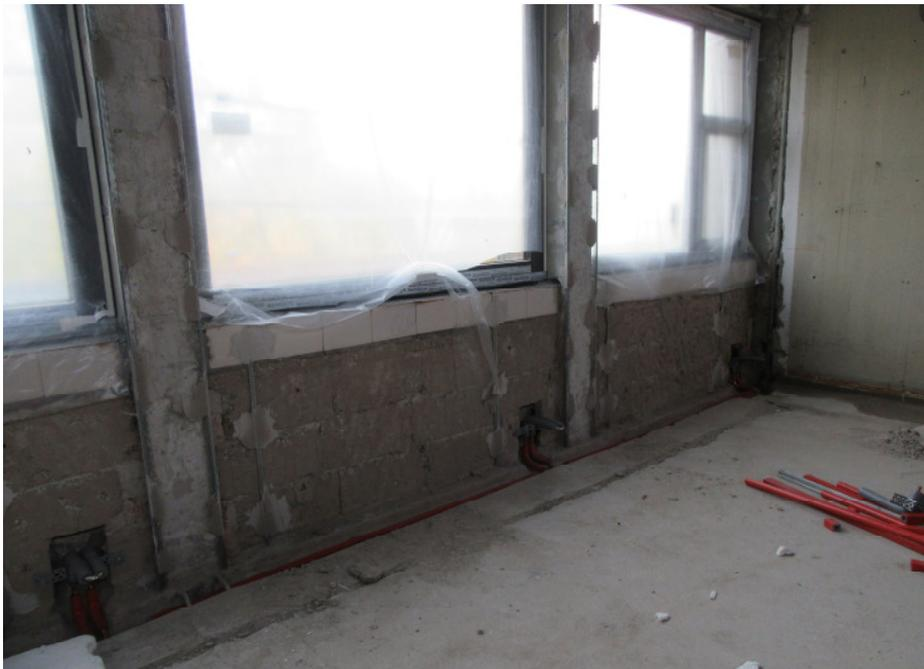
Für die Innenputzarbeiten wurden von der beauftragten Firma Eckschienen an Leibern gesetzt, damit nach Freigabe der Leitungen und Verschließen der Aussparungen mit den Innenputzarbeiten begonnen werden kann.
