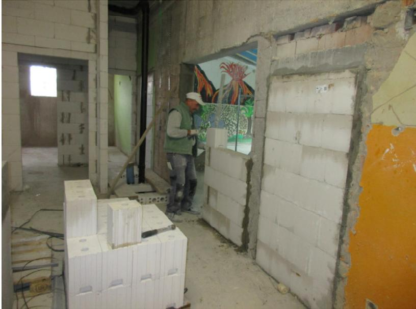
Sobald die letzten Wanddurchbrüche zugemauert sind, können auch die Rohbauarbeiten im Gebäude abgeschlossen werden.
