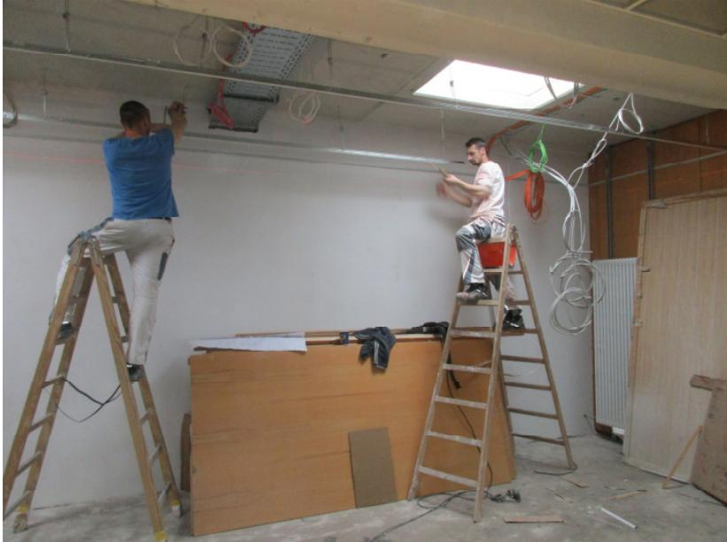
Parallel hierzu werden EDV-Kabel gezogen, die Bodenleger haben mit Vorbereitungsarbeiten und Estrichausbesserungen begonnen und alle Räume selbst erfahren eine erste grobe Baureinigung.
