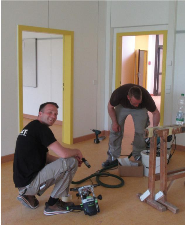
Im Gebäude B (Grundschule) laufen dieser Tage die letzten Arbeiten am Innenausbau, bevor die Endreinigung erfolgen wird. Vom Schreiner werden die restlichen Türschlösser und Beschläge angebracht und die Türen eingestellt.
