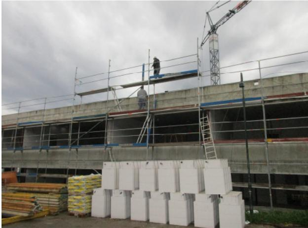
Um die Arbeiten auf dem Flachdach sicher ausführen zu können, muss zunächst das Gerüst erhöht werden.
