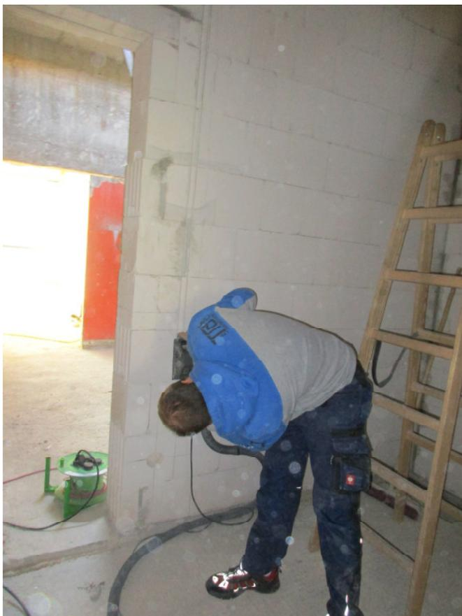
Die Elektriker mischen in diesem Bereich ebenfalls kräftig mit und verlegen Leitungstrassen. Mit Hilfe einer Fräse werden die Kabeltrassen in die Mauerwände gefräst.
