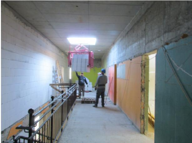
Nur gut, dass es künftig Lichtkuppeln in der Decke gibt. Durch diese Aussparungen können palettenweise die Kalksandsteine mit Hilfe des Krans abgelassen werden,
