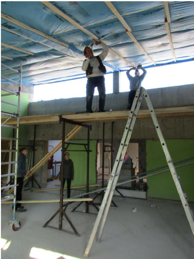
Im Gebäudeinneren des Bestandsgebäudes wird an der Dämmung des Dachraumes gearbeitet.
