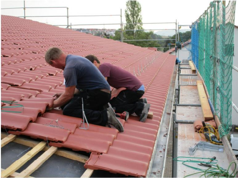
Derzeit werden die letzten Ziegel am Bestandsgebäude montiert, worauf hin die Solaranlage wieder installiert werden kann.
