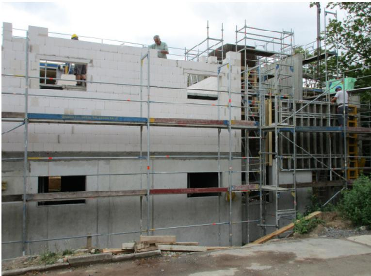
Die Maurerarbeiten im ersten Obergeschoss wurden unmittelbar nach Aushärten der Decke fortgesetzt. Im Bereich des Treppenhauses werden Fahrstuhlschacht, sowie Betonaußenwände des Treppenhauses eingeschalt.
