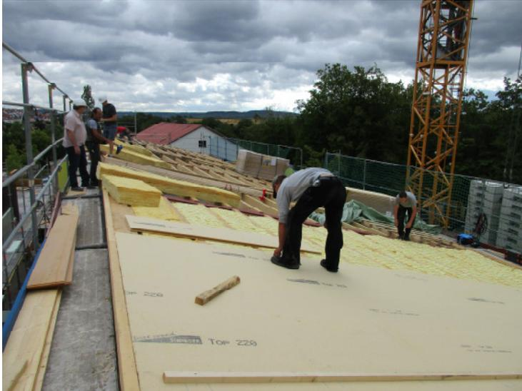
Auf der Dachhälfte des Bestandsgebäudes hat die Firma Stopper in der letzten Woche das Dach aufgeschlagen. Nun wird die Wärmedämmung aufgebracht.
