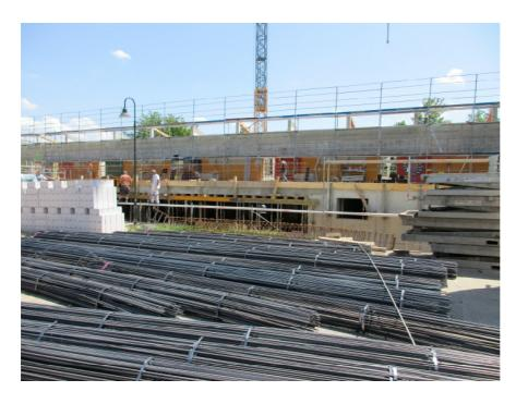
Tonnen von Baustahl, die in vorgefertigten und aufgerollten Matten auf die Baustelle geliefert werden, wurden für die Armierung eingebaut, ehe zum Wochenende das Teilstück betoniert werden konnte.
