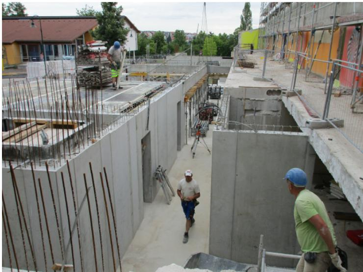
Nachdem in der letzten Woche schon ein Teil der Wände im Neubaubereich des Gebäudes A fertiggestellt wurde, werden in dieser Woche die Schalarbeiten an der ersten Decke ausgeführt. Zuvor wurden im Obergeschoß des Altbaus Oberzüge aufbetoniert, damit hier in Kürze die Zimmermannsarbeiten beginnen können.
