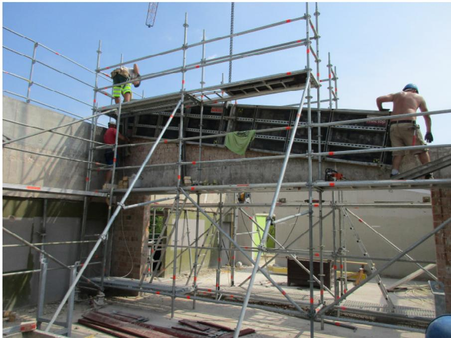
*Der Oberzug wird eingeschalt und betoniert, damit eine Auflage für die Dachkonstruktion geschaffen wird.*
