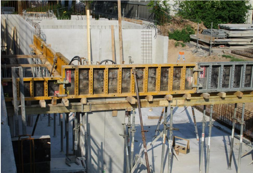
Nachdem in der letzten Woche die Bodenplatte betoniert und Schalarbeiten von Wänden ausgeführt wurden, stehen nun das Einschalen, Armieren und Betonieren von Unterzügen im Anbauteil von Gebäude A an. Im ersten Stock werden auf die Zwischenwände des Bestandsgebäudes noch Betongurte aufgesetzt, damit in Kürze die Zimmerer ihre Tätigkeit aufnehmen können.
