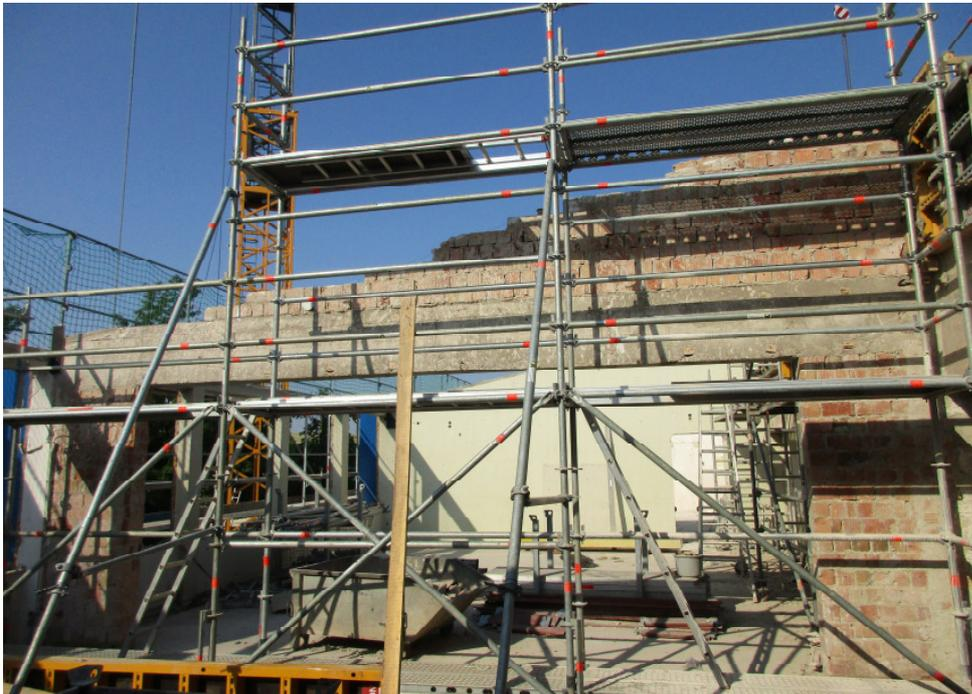
Im Erdgeschoss war eine tragende Wand im Wege. Diese wurde durch Betonsägen ausgeschnitten und beseitigt.
