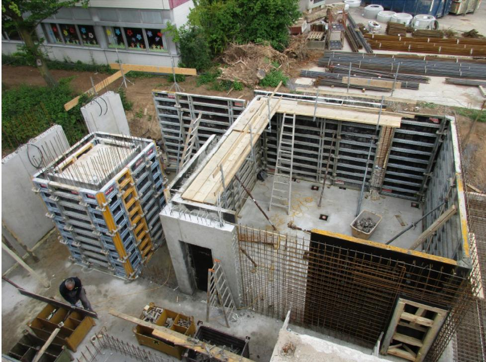
Fahrstuhlschacht und Treppenhauswände werden eingeschalt und betoniert.
