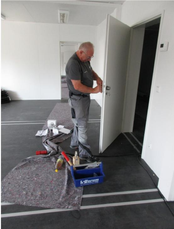
*Zarge und Türblatt sind montiert. Abschließend wird der Schließzylinder eingesetzt.*
