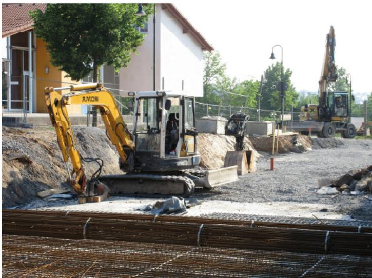
*Baustahlmatte für Baustahlmatte wird verlegt, um der Bodenplatte die nötige Stabilität zu verleihen.*
