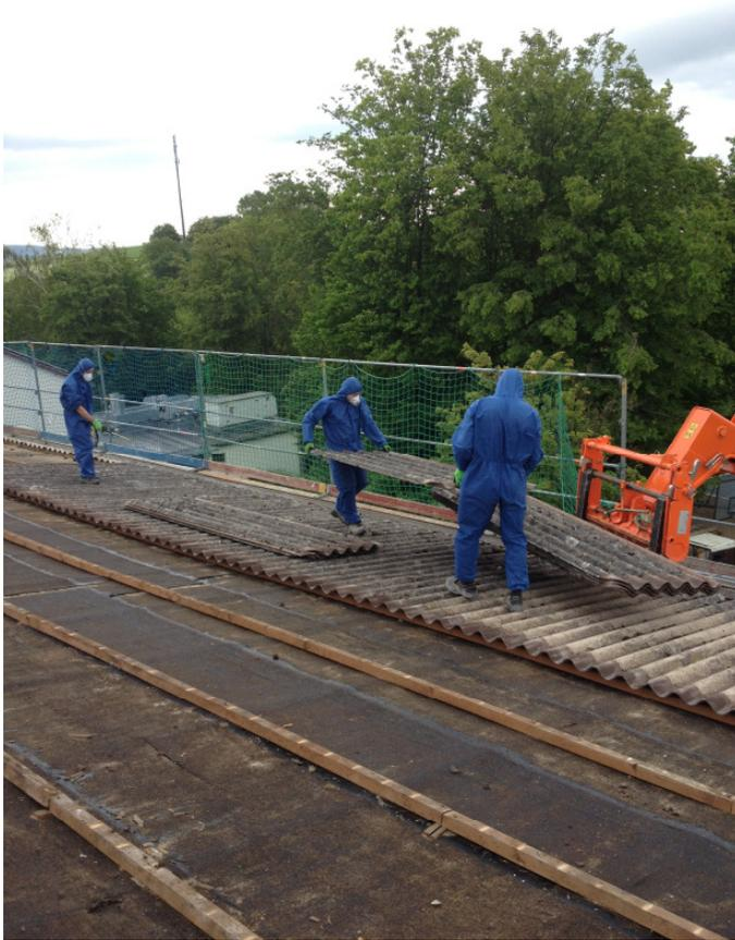
*Zunächst wurden die Dachplatten abgebaut, ehe die Unterkonstruktion beseitigt werden konnte.*
