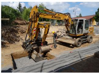
Die Fundamentgrube für den Fahrstuhlschacht wird vorbereitet.
