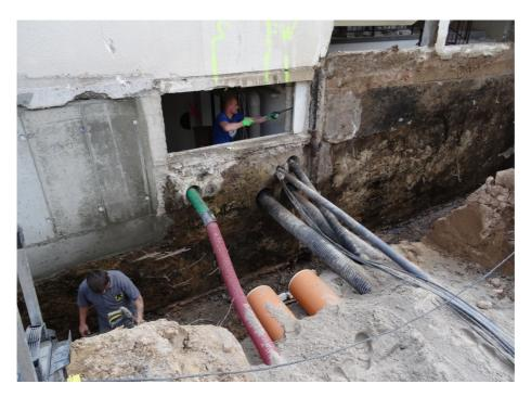
Auch zahlreiche Mauerdurchführungen müssen so abgedichtet werden, dass später keine Feuchtigkeit eindringen kann.
