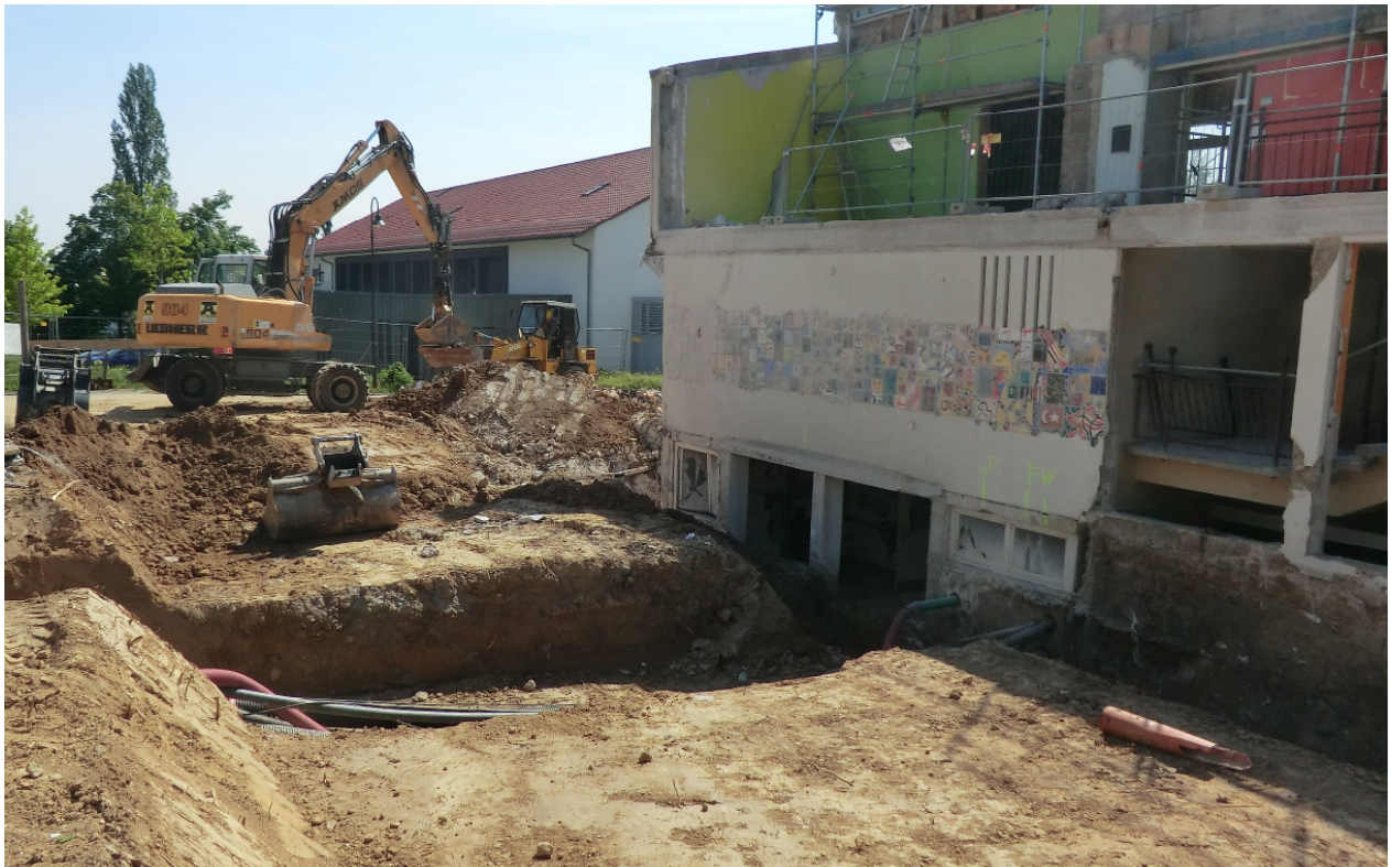
Das Rohplanum für den Gebäudeanbau steht.
