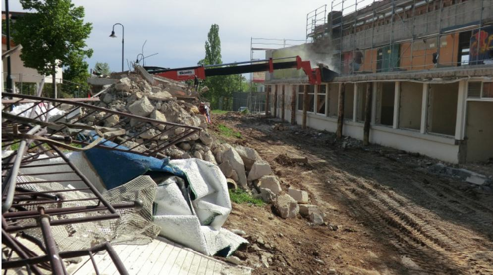
*Abfalltrennung heißt das Schlagwort. Zunächst werden die Abbruchbestandteile seitlich des Gebäudes gelagert, ehe das Material nach Sorten getrennt in Containern beseitigt wird.*
