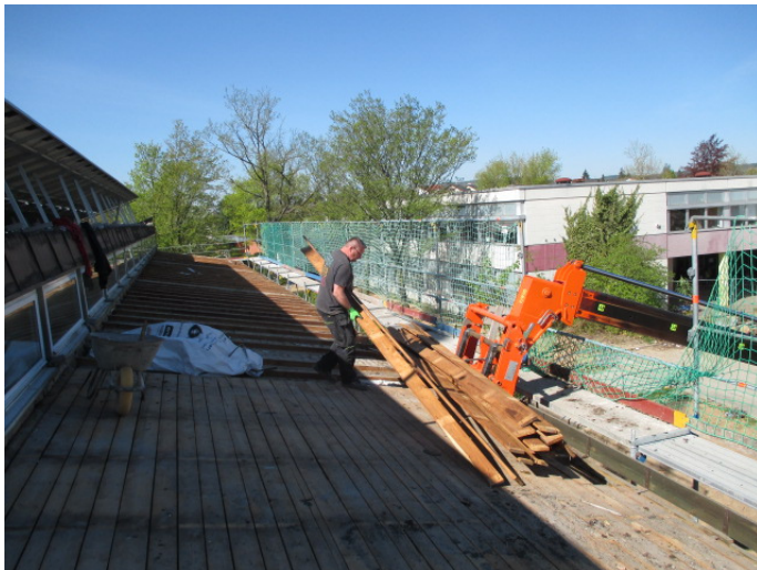
Die Dachkonstruktion über dem Flur des Hauptschulgebäudes wird abgebrochen.
