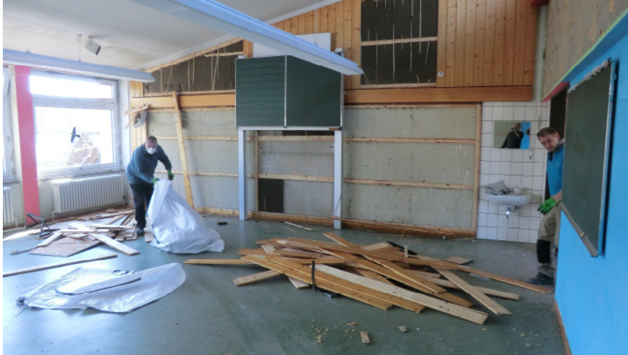
Leitungen werden demontiert und in Klassenräumen und Fluren die Einbauten abgebrochen.
