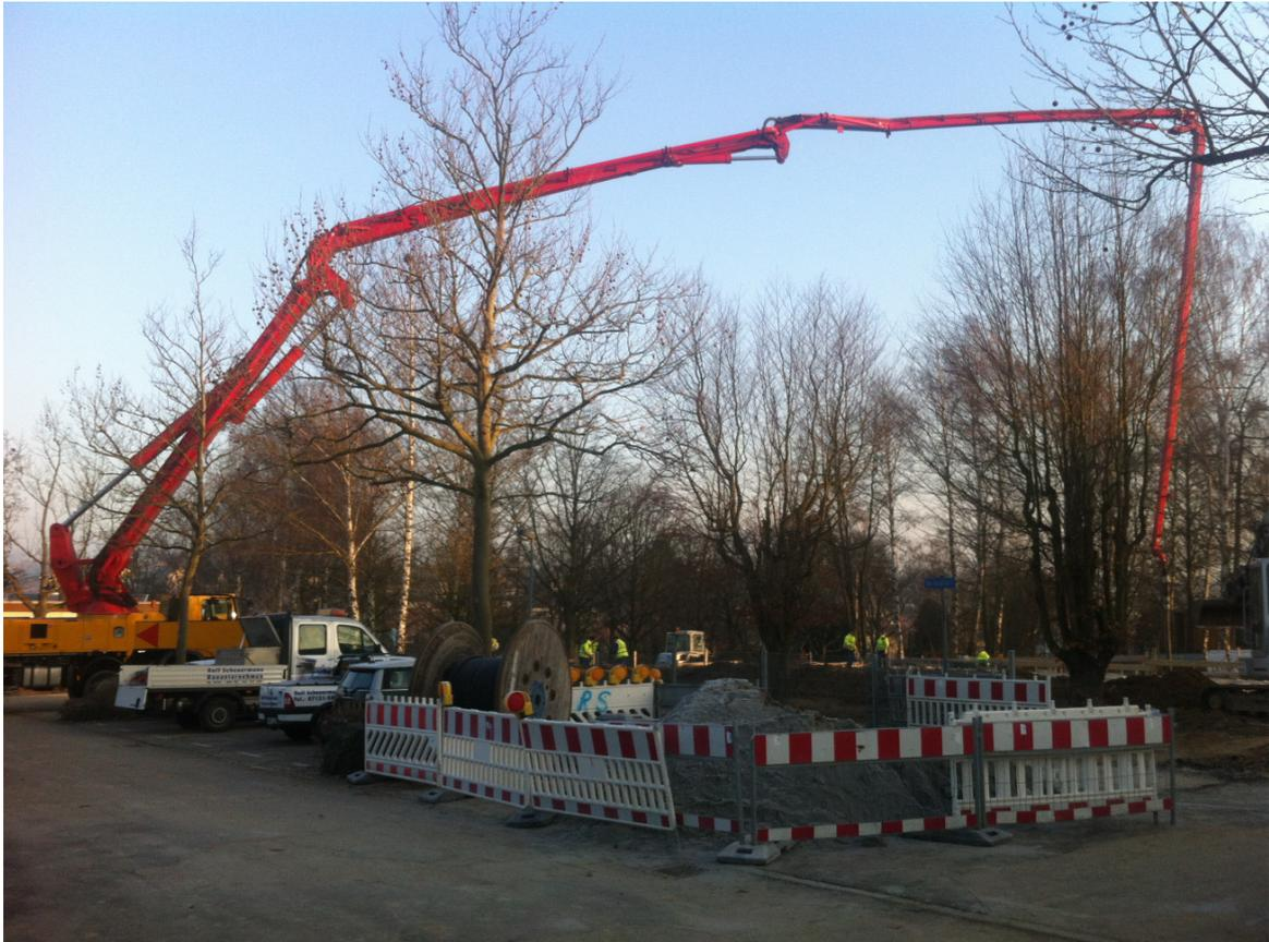
*Mit Hilfe einer Betonpumpe wurde der Fundamentbeton in die Streifenfundamente eingebracht.*
