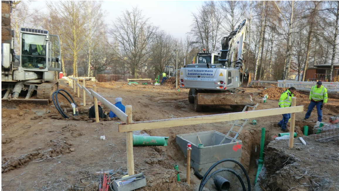
Unser Bild zeigt das Baufeld für den Pavillon P2 parallel zur Straße „Im Geißbühl“.
