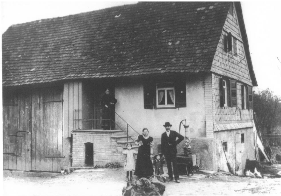
Hausbrunnen vor der früheren Poststelle (heute Schulweg)
