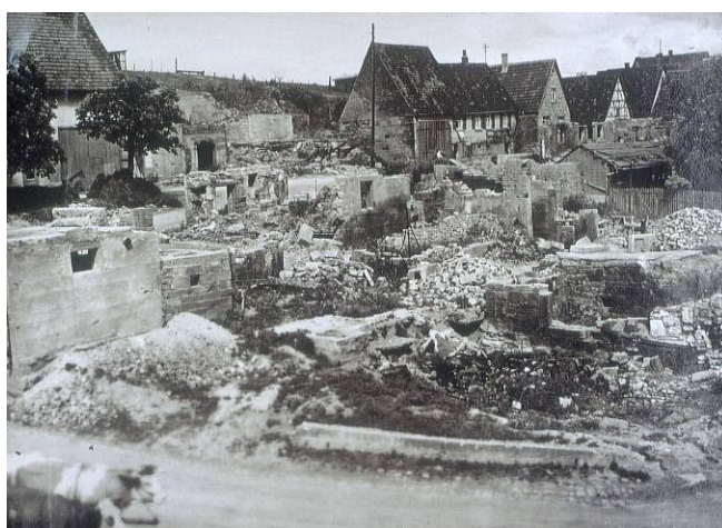
Zerstörungen an der Ecke Hauptstraße und Großgartacher Straße; oben: Kelterstraße
