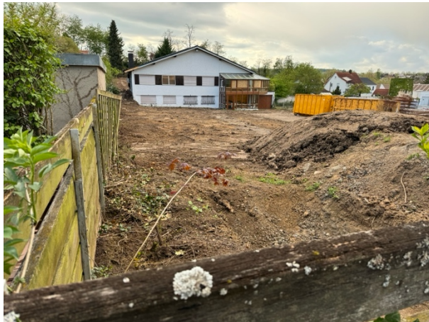
Abb. 2: Plangebiet aus östlicher Richtung von der Straße Im Auerberg aus betrachtet.
