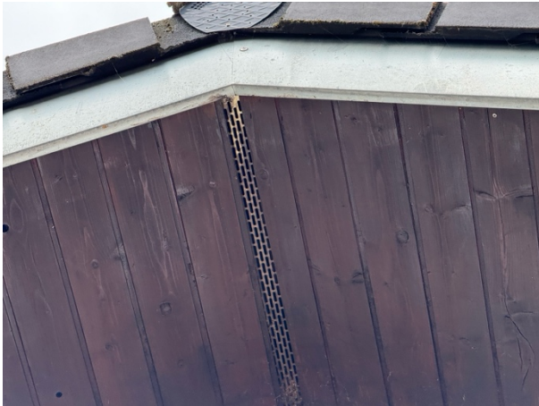
Abb. 8: Östliche Giebelunterseite mit breitem Dachüberstand ohne tierökologische Funktionen.
