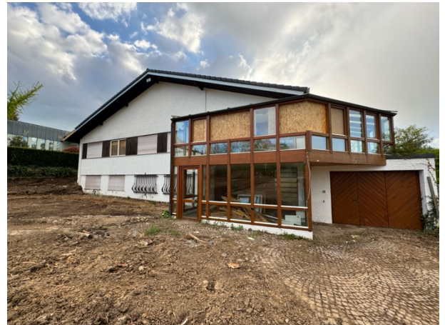
Abb. 3: Blick auf das abzubrechende Wohngebäude aus Nordosten.
