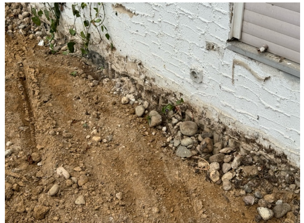
Abb. 5: Kieselsteine als Spritzwasserschutz an der Basis einer Hauswand.
