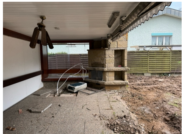
Abb. 13: Überdachte Terrasse an der Westseite ohne Hinweise auf eine tierische Nutzung.
