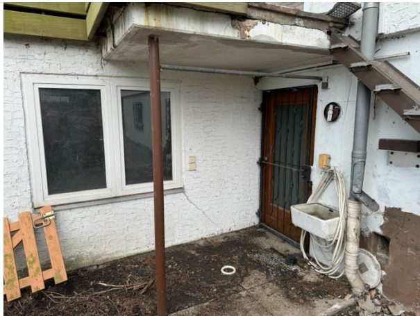
Abb. 14: Kleine Überdachung an der Nordseite ohne Hinweise auf eine tierische Nutzung.
